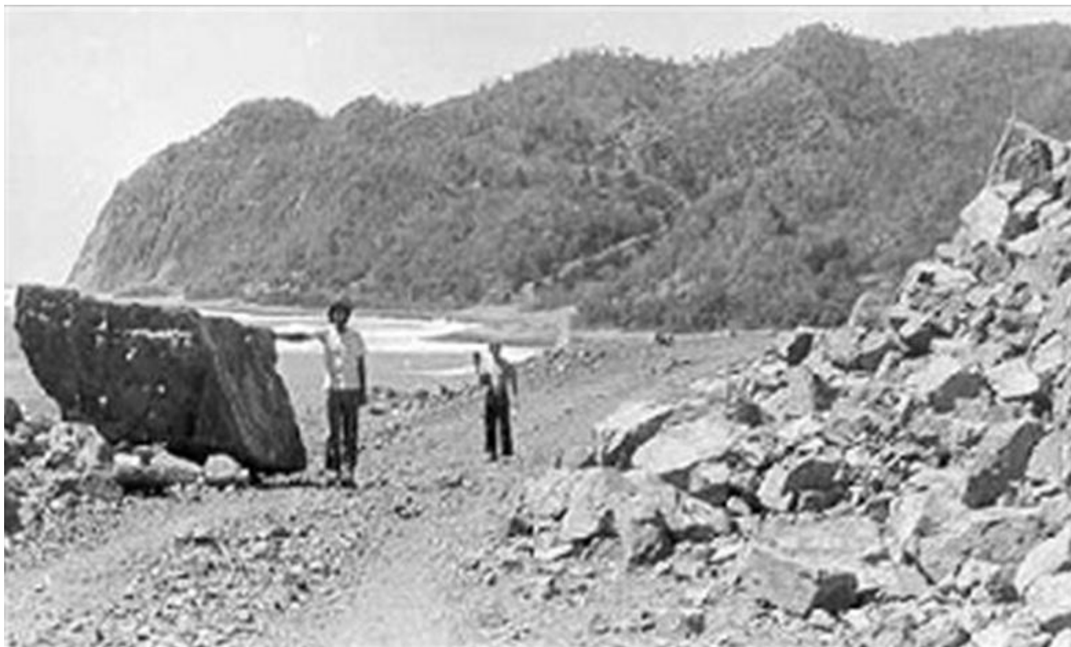
Figura 29. Deslizamiento de rocas asociado al terremoto de Pílon de 1976, en Purialón. Cortesía del Dr. Tomás Chuy Rodríguez.
