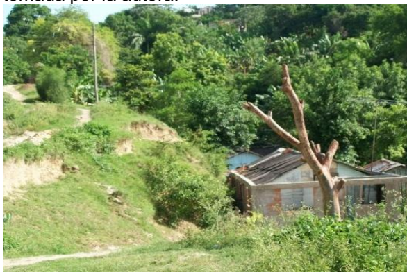
Figura 36. Vivienda ubicada cerca del pie del talud en calle Varadero, Altamira. Santiago de Cuba. Foto tomada por la autora.
