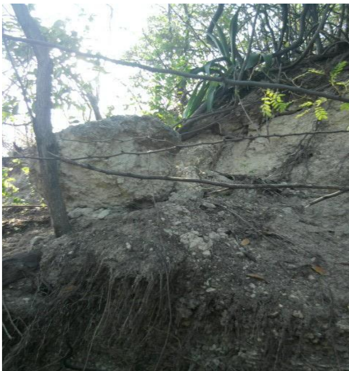
Figura 57. Desprendimiento de roca al este de la bahía de Santiago de Cuba. Foto tomada por la autora
