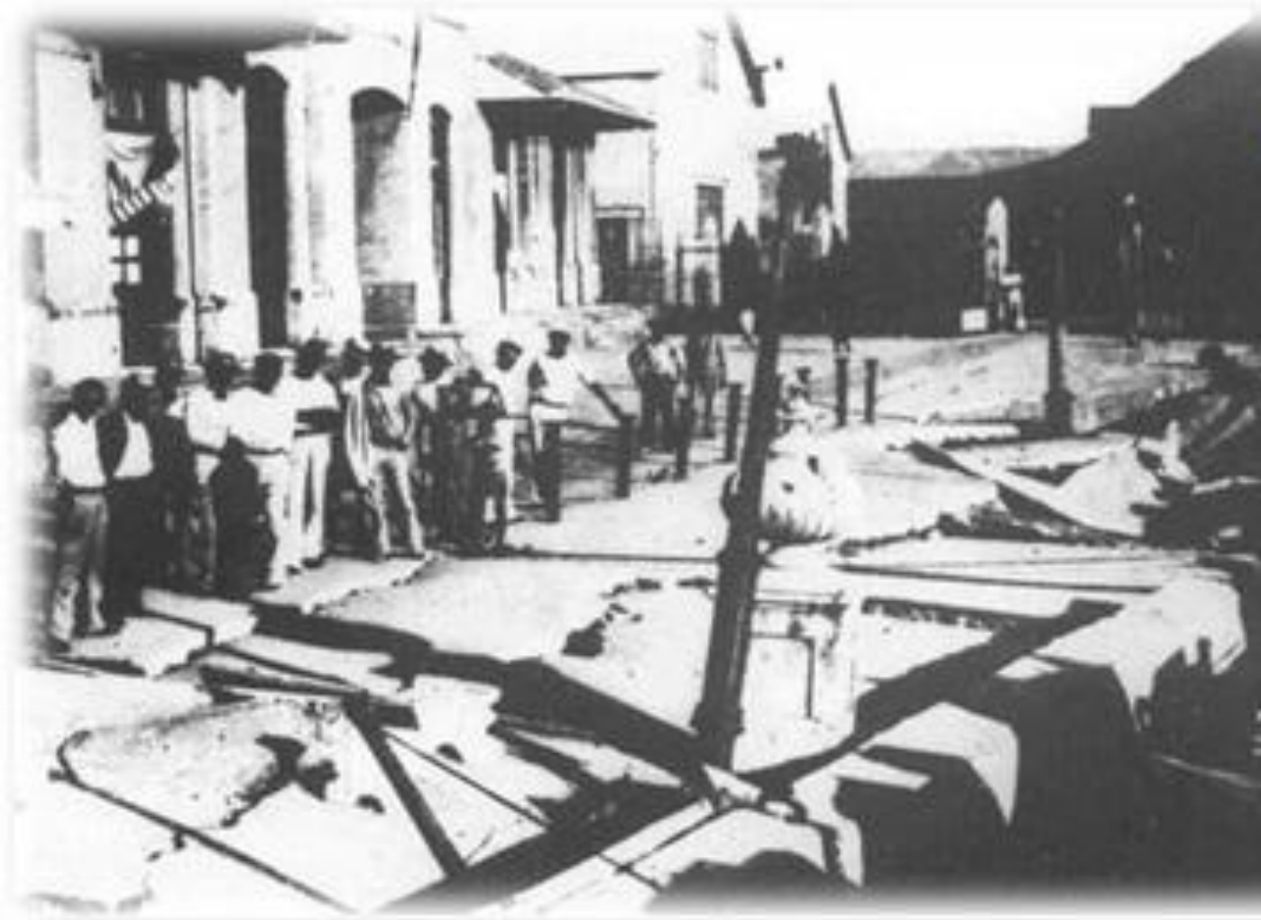
Figura 50. Probable ocurrencia de licuefacción de suelo, en la zona de la Alameda (Avenida Jesús Menéndez), causada por el terremoto del 3 de febrero de 1932. Fuente: Chuy, 1999.
